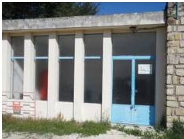
La station de pompage de l'eau du Rieu
